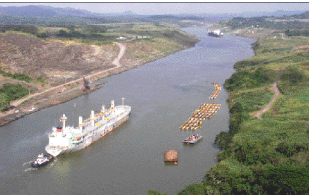
En la imagen superior, una embarcación cruza el Paso Gaillard, el punto que obligó a adoptar el sistema de esclusas en lugar de uno de paso a nivel. Ala izquierda, una imagen del 20 de noviembre de 1911, que muestra el uso del ferrocarril para transportar escombros en ese mismo sitio, cuando se le conocía como Paso Culebra.- (AP)
